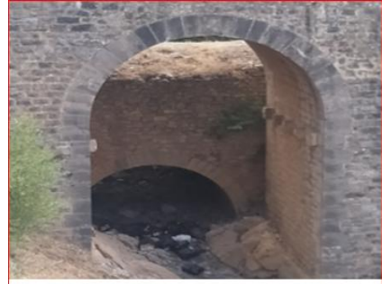
Pont voutée جسر مقنطر
