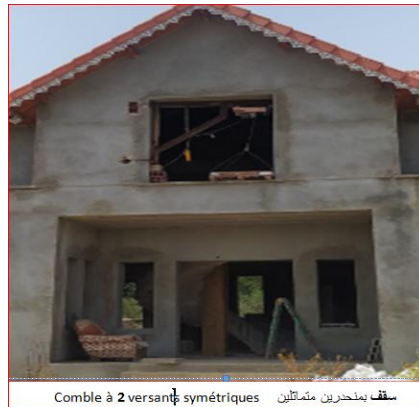
سقف بمنحدرين متماثلين Comble à 2 versants symétriques
