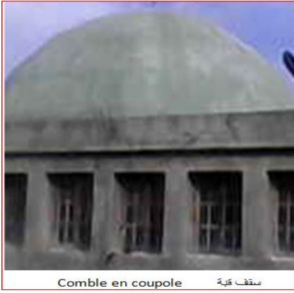
Comble en coupole سقف قبة
