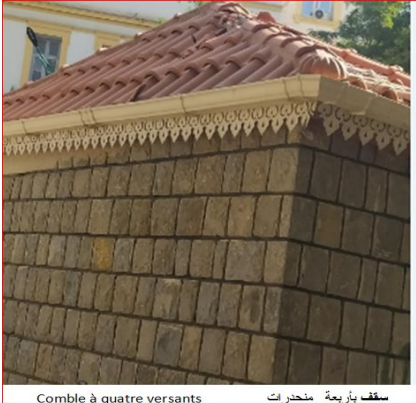
سقف بأربعة منحدرات Comble à quatre versants
