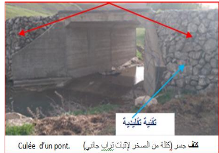
Culée d'un pont. كتف جسر (كتلة من الصخر لإتبات تراب جانبي) تقنية تقليدية
