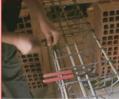
حدائدي (المكلف يربط حديد البناء) Ferrailleur
